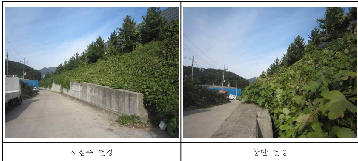
<그림 1.1.1> 대동판넬진입로옹벽(10공구) 전경
