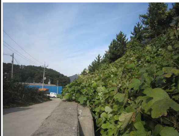
상부 배수로 전경
